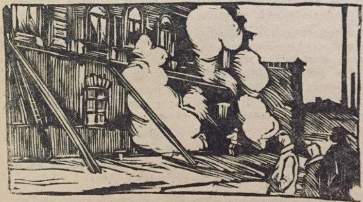
Здание театра во время пожара, вид с Подсинской улицы.
